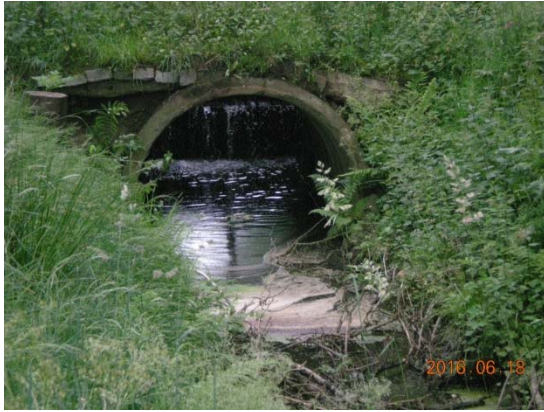
Absturz im Auslauf des Sandfanges
