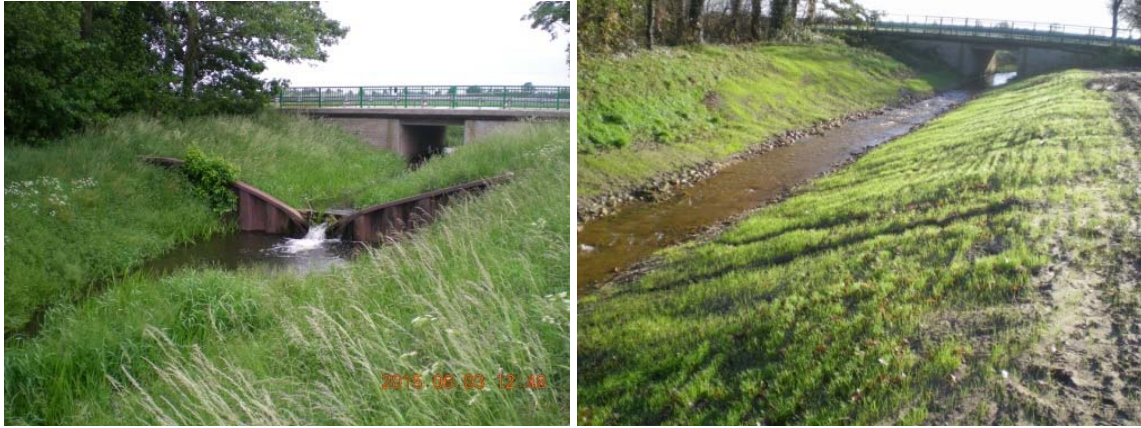
Schaffung der Durchgängigkeit durch Herstellung einer Sohlgleite in der Lotter Beeke, LK Emsland
