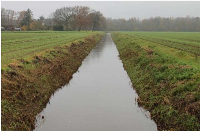
Ausgebauter und begradigter Bühnerbach ohne Randstreifen, LK Osnabrück und Oberflächenwassereinleitung in den Vechtaer Moorbach, LK Vechta
