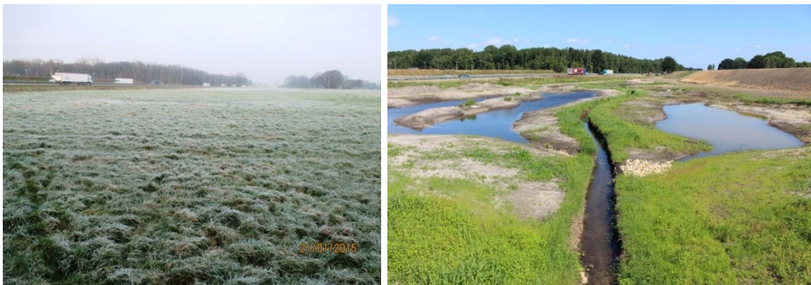
Verlegung des Schierenbaches mit Anlage einer Sekundäraue, Landkreis Vechta
