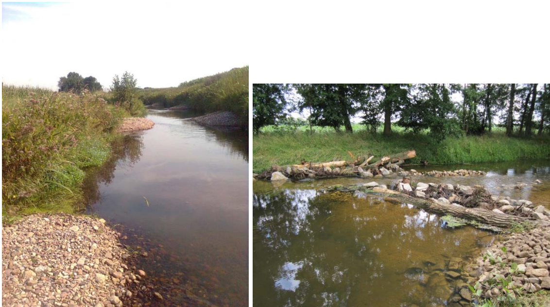
Einbau von Strömungsenker im Calhorer Mühlenbach, LK Cloppenburg und in der Bever, LK Osnabrück
